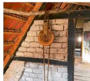
Ausgemauertes Fachwerk unter dem Dach.
